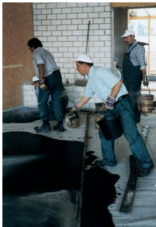
Einbau und fertige Fläche
