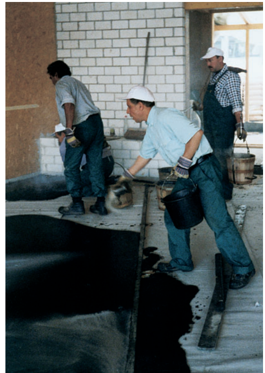
Einbau und fertige Fläche
