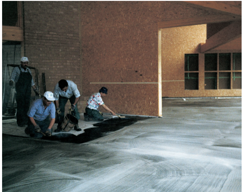
Einbau und fertige Fläche
